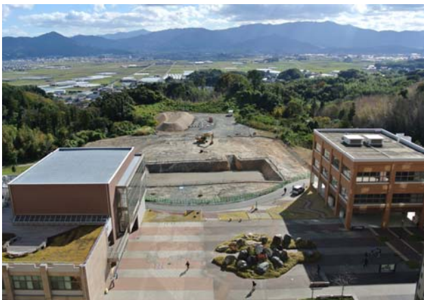
施工中の空隙貯留浸透施設（3基目）
