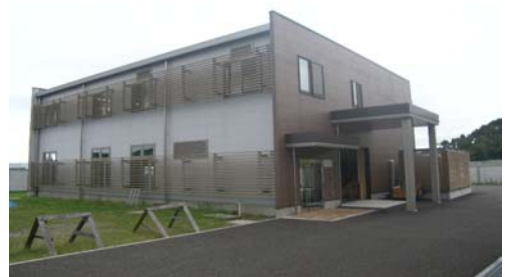
写真 1 エコセンター
