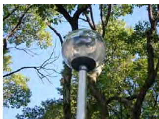
(改修前) 水銀灯 250W
