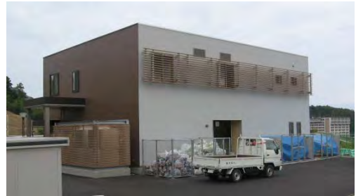
写真 1 エコセンター
