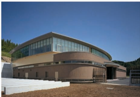
給水センター(再生水処理施設)
