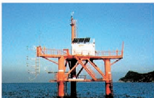
対馬海峡に設置された海洋レーダー
