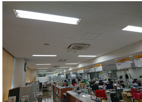
(改修前) 蛍光灯
