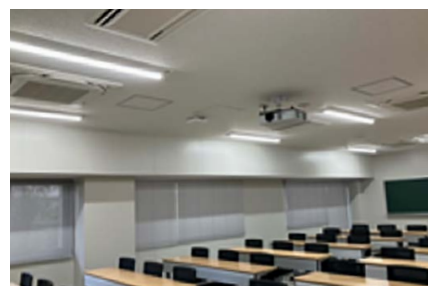
改修後（LED照明）
