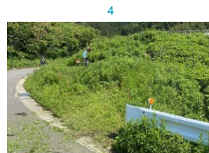
4 刈払い機での除草作業
