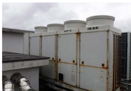
改修前（室外機）
