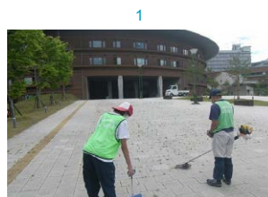
1 広場の除草作業
