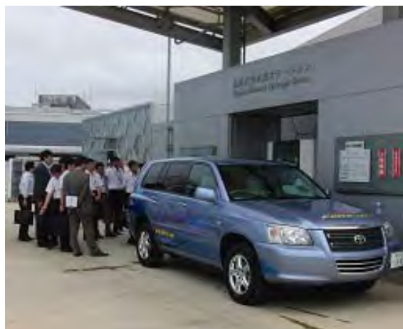
水素ステーション
