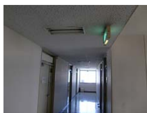
(改修前) 20W×2 蛍光灯
