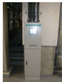
(改修後) 省エネルギー制御盤の設置
