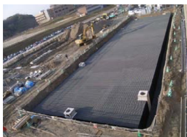
施工時の状況
