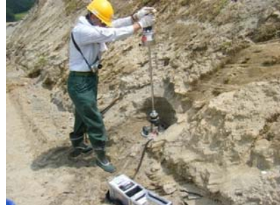
ポタ山における平板載荷試験の様子
