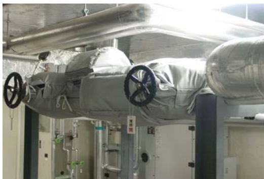
蒸気バルブの保温
