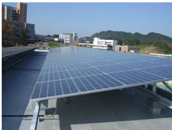
課外活動施設屋上の太陽光発電(平成21年度)
