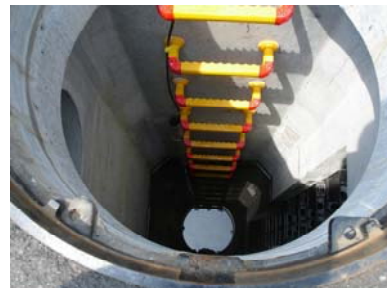
管理用マンホール
