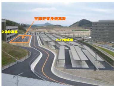
完成後の状況
