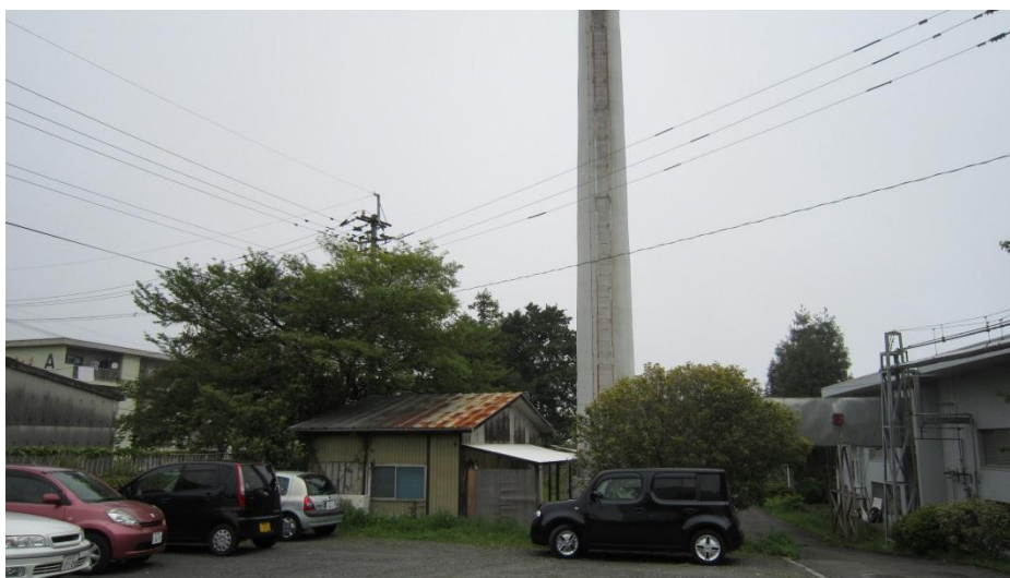
撤去前のボイラー煙突
