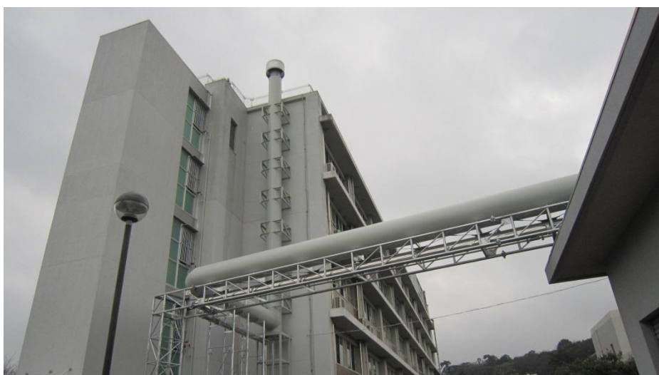
新設ボイラー煙突
