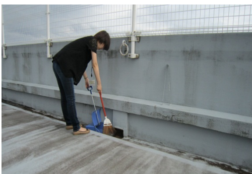
建物屋上清掃
