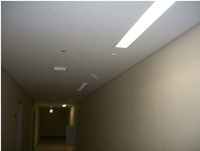
【間引き点灯の様子 病院外来棟5階】
