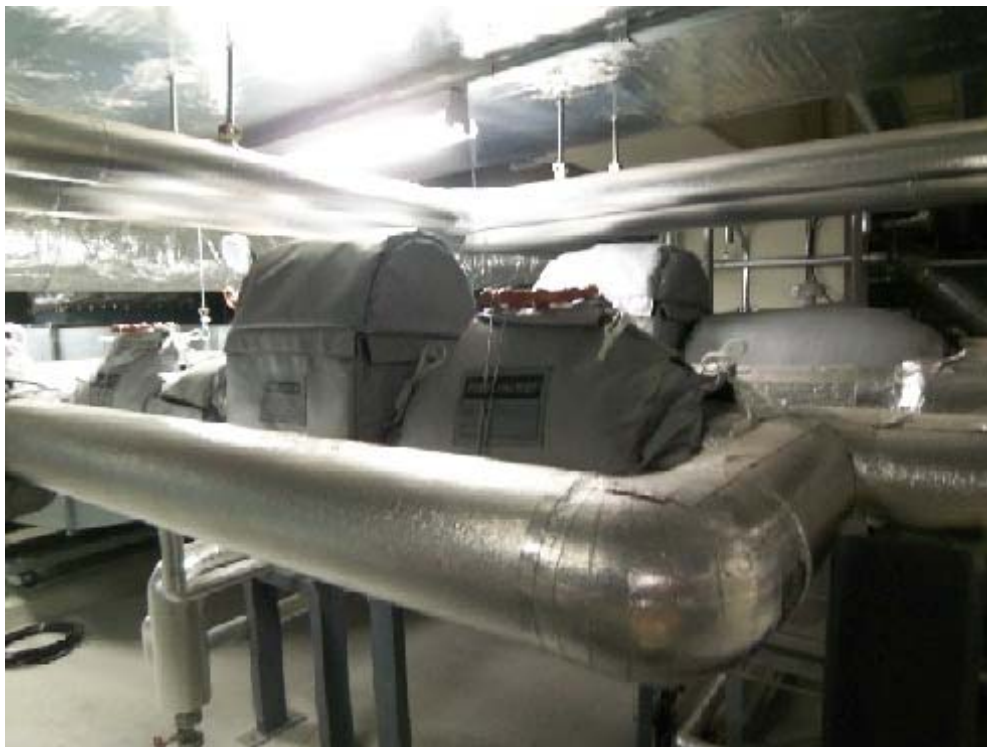
【蒸気弁装置の保温】
