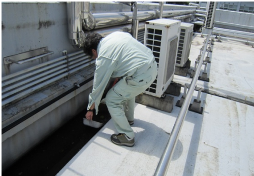
建物屋上清掃
