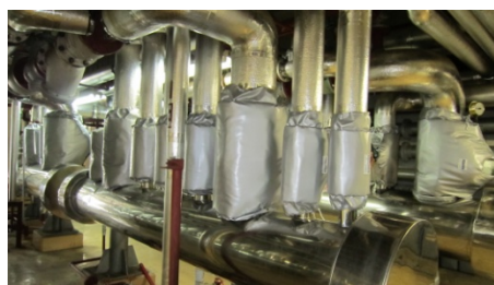
バルブジャケット取付後
