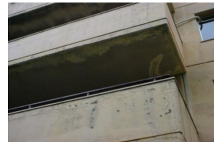
老朽化した外壁
