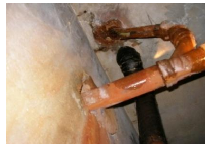
老朽化した給排水配管
