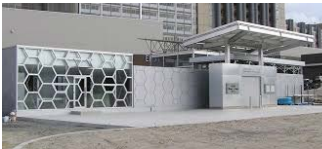
九州大学「水素ステーション」
