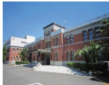
本部第一庁舎 (大正14年建築)
