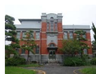
本部第三庁舎 (大正14年建築)
