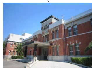
本部第一庁舎 (大正14年建築)
