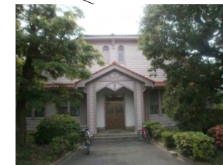
熱帯農学研究センター (昭和6年建築)
