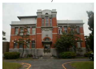
本部第三庁舎 (大正14年建築)
