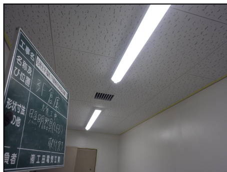
(改修後) LED照明
