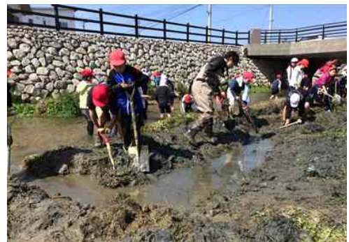
子どもたちと大学生の協働による生き物の生息場造成の工事の様子
