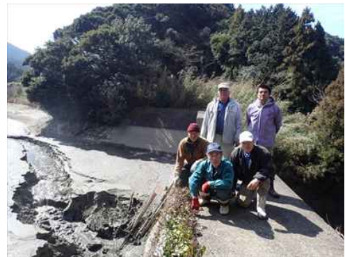
地域と協働で実施した砂防堰堤のゲート構造改善
