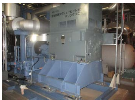
(改修後) 圧縮機ユニット (高効率型)
