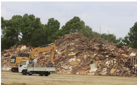
図 4 発災当時の西原村仮置場の状況
