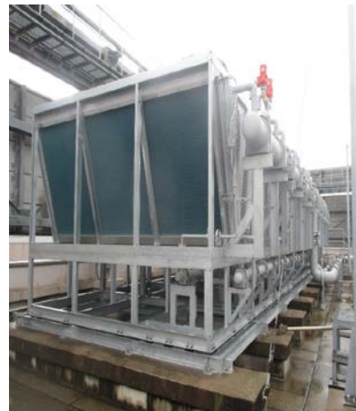
(改修後) 空気熱交換器 (省エネ型)
