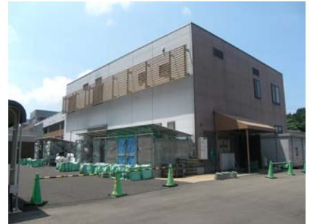
写真 1 エコセンター
