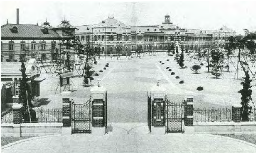
旧九州帝国大学工科大学本館を望む(明治44年頃)
