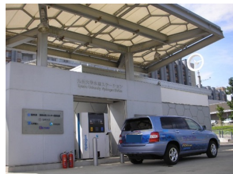
■九州大学の先進技術〈水素ステーション〉
