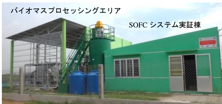
図 1: メコンデルタ (ベトナム・ベンチェ) のエビ養殖場内に構築したエネルギー循環システム実証プラント
