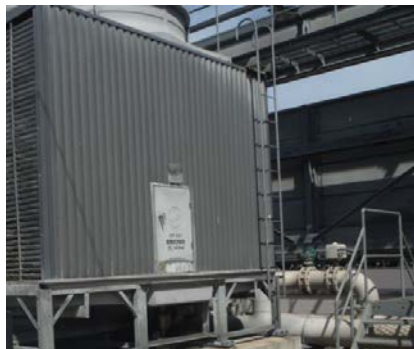
(改修前) 冷却塔
