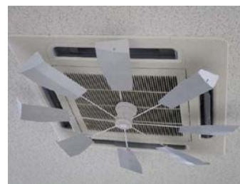
羽根による空調機の効率化
