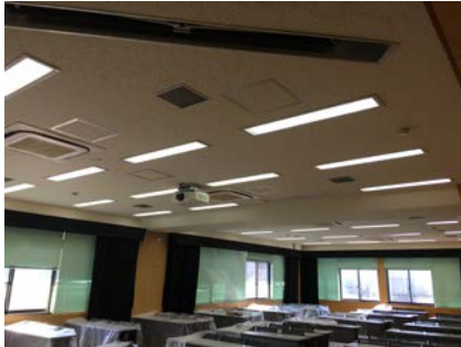
(改修前) 蛍光灯
