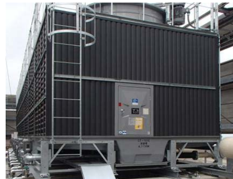
(改修後) 冷却塔 (高効率型)
