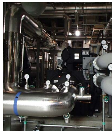
(改修後) ターボ冷凍機 (高効率型)
