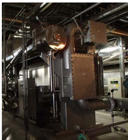
(改修前) 吸収式冷凍機
