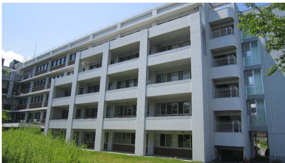
病棟南側耐震補強
