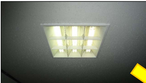
取替前(36W×3 蛍光灯)
