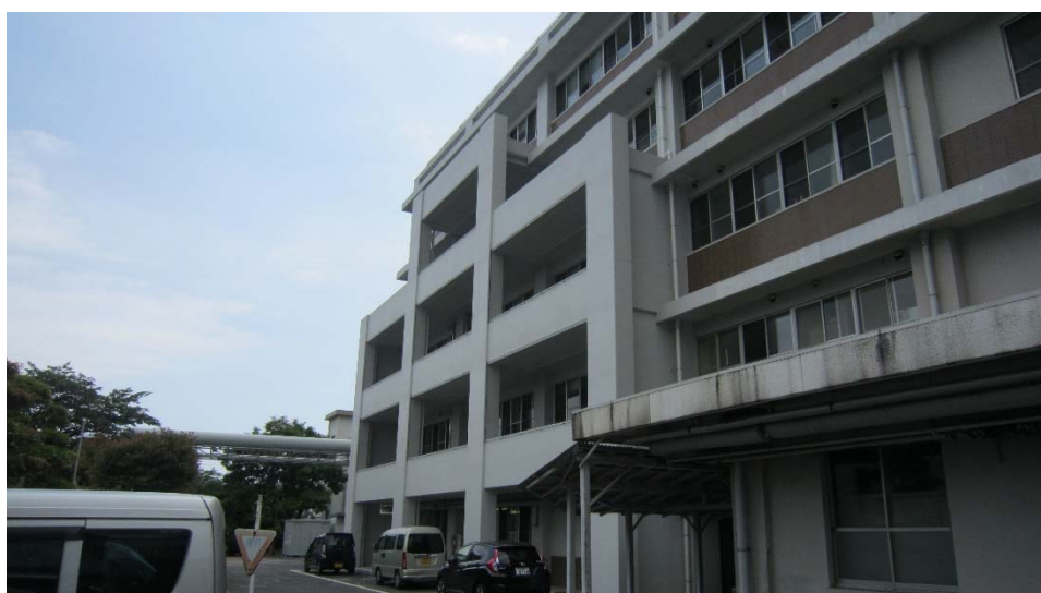
病棟北側耐震補強
