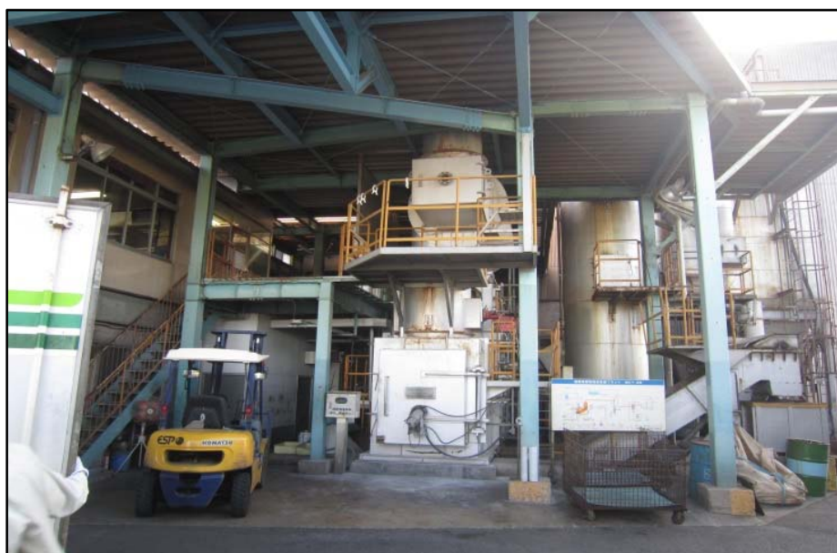
産業廃棄物焼却処理プラント
