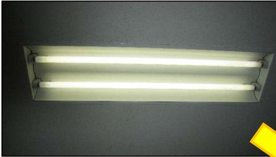
取替前(40W 蛍光灯)
