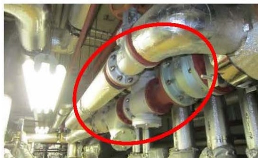
② 保温工事（改修前）
