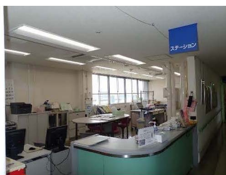
① ナースステーションLED（改修後）
