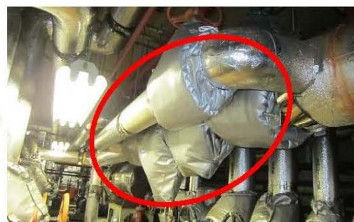
② 保温工事（改修後）
