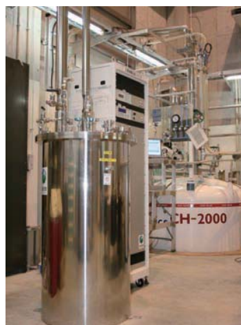
図2 超伝導装置冷凍装置と液体ヘリウム容器
