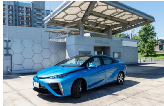
水素ステーション
