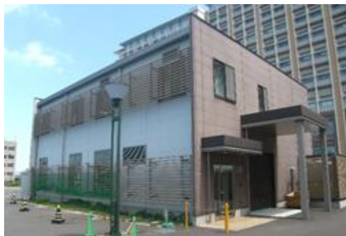
写真 1 エコセンター
