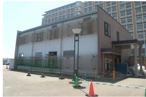
写真 1 エコセンター
