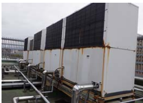
(改修前) 室外機
