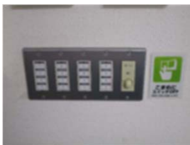
事務室照明スイッチ付近
