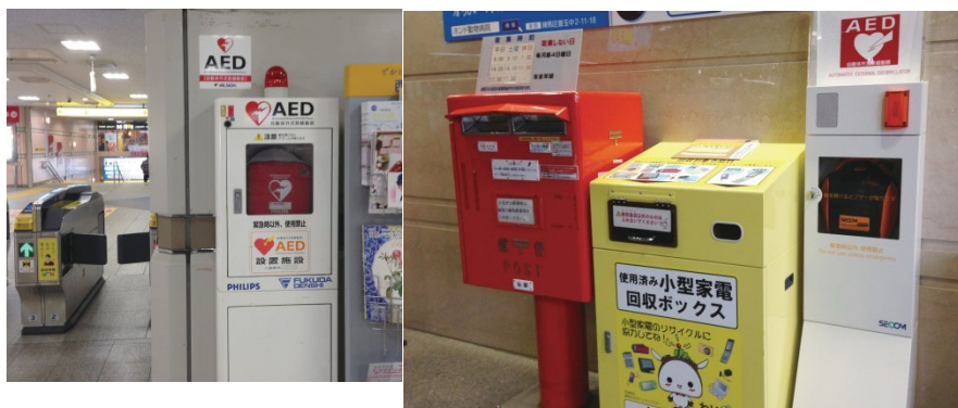
図13.7 AEDの設置状況事例（厚生労働省、2015）
