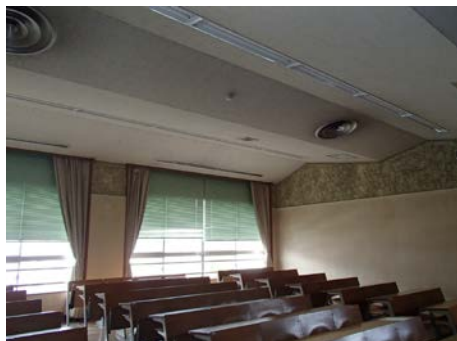
(改修前) 蛍光灯
