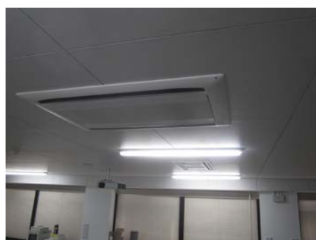
(改修後) 高効率空調用室内
