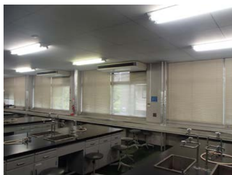
(改修前) 空調用室内機
