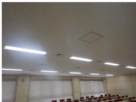
(改修後) LED照明
