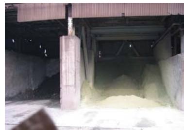
回収金属のストックヤード
