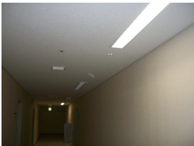
【間引き点灯の様子 病院外来棟5階】
