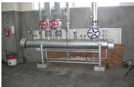
バルブジャケット取付前
