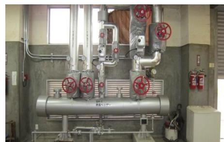
バルブジャケット取付後
