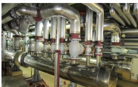
バルブジャケット取付前
