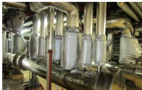
バルブジャケット取付後
