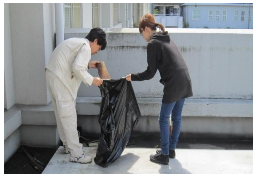
建物屋上清掃
