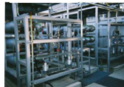
蓄圧器エリア
