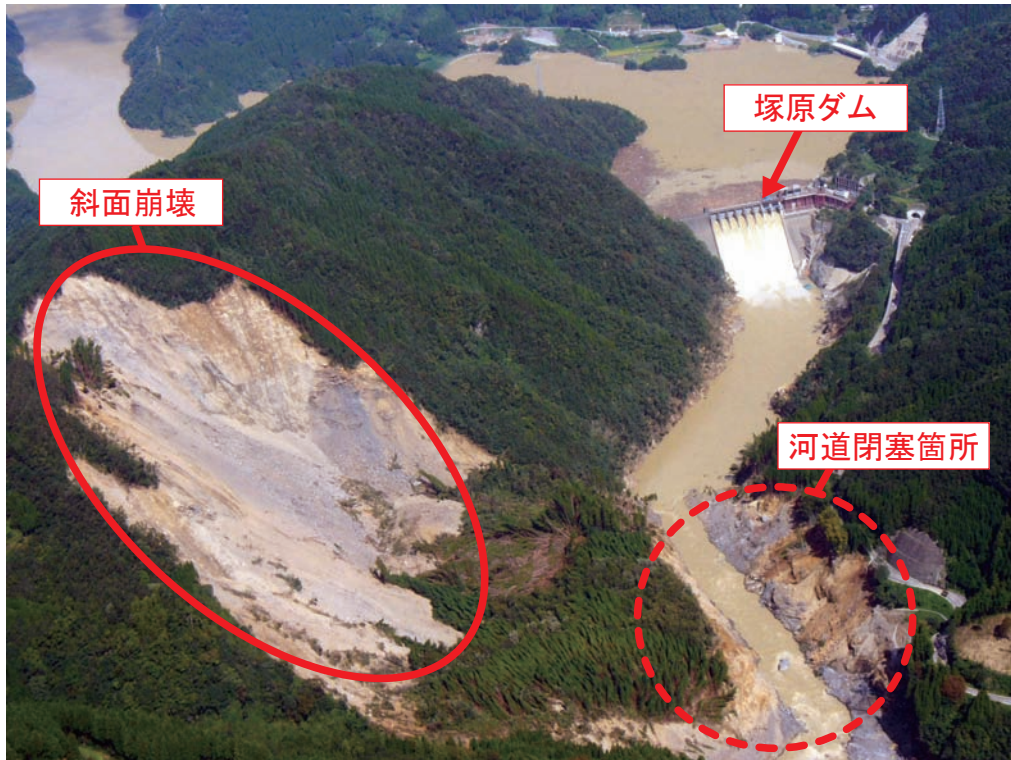
塚原ダム下流における斜面崩壊
