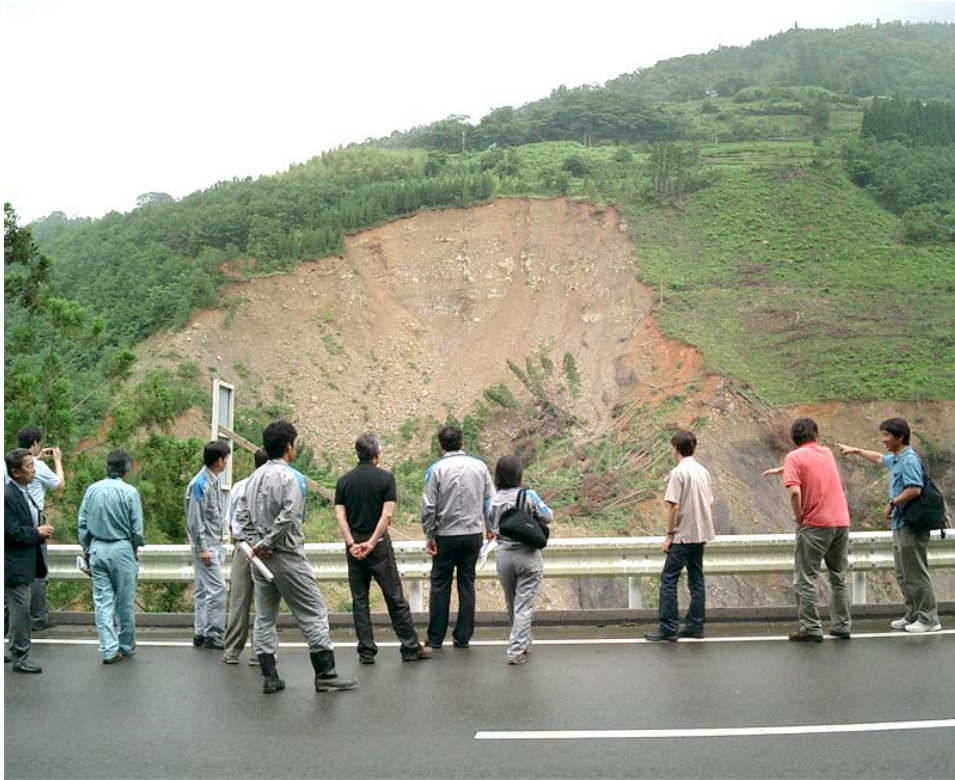
大規模崩壊現場の視察の様子
