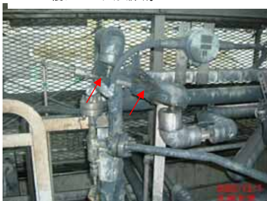
写真3 酸素分離タンク上部（写真中央下）：3つに分かれた配管のうち、左右の配管（赤矢印）には膨れがみられ、中央の配管は飛散した。青矢印で示した被覆チューブが破断。
