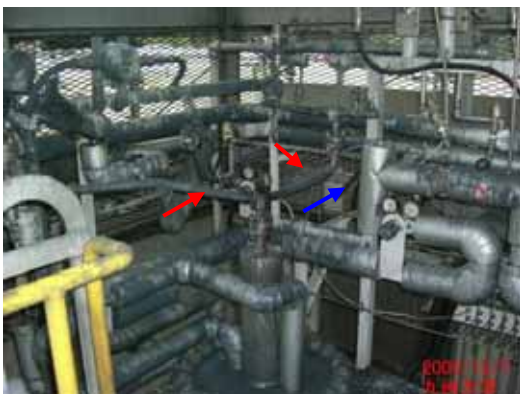
写真3 酸素分離タンク上部（写真中央下）：3つに分かれた配管のうち、左右の配管（赤矢印）には膨れがみられ、中央の配管は飛散した。青矢印で示した被覆チューブが破断。
