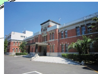
本部第一庁舎 (大正14年建築)
