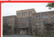
応用物質化学機能教室 (昭和2年建築)
