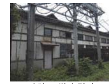
砂防工学実験室 (昭和9年建築)
