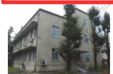
記録資料館 (昭和12年建築)
