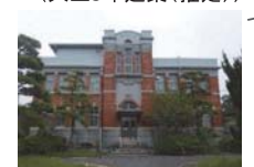
本部第三庁舎 (大正14年建築)
