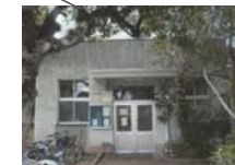
留学生センター分室 (昭和4年建築)
