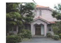
熱帯農学研究センター (昭和6年建築)
