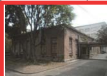
工学部高温化学実験室 (昭和7年建築)
