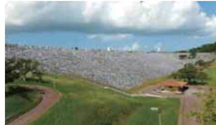
倉敷ダム (沖縄県うるま市)
