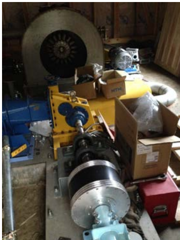
写真：糸島市白糸の滝発電所 (インドネシアHeksa社製クロスフロー10kW)
