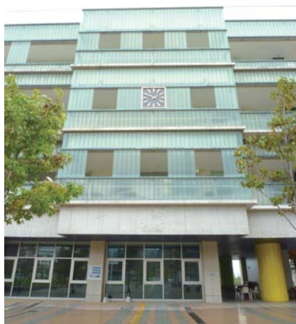
「みの刻み」を設置
