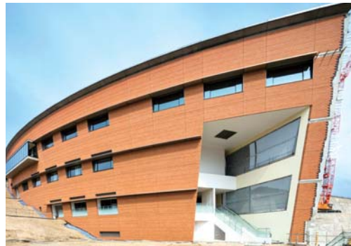
プレオープンした3分の1(第1期工事)の部分
