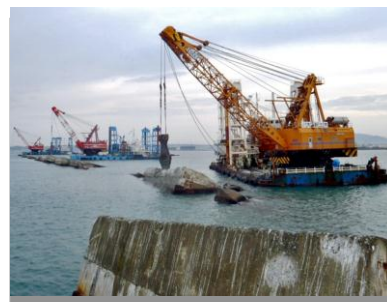
八戸港北防波堤
