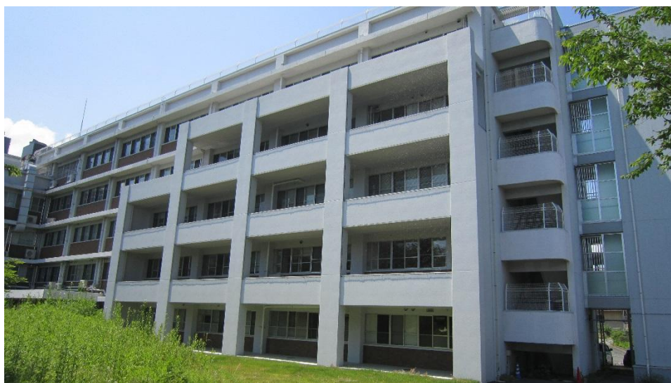
病棟南側耐震補強
