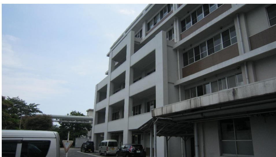
病棟北側耐震補強
