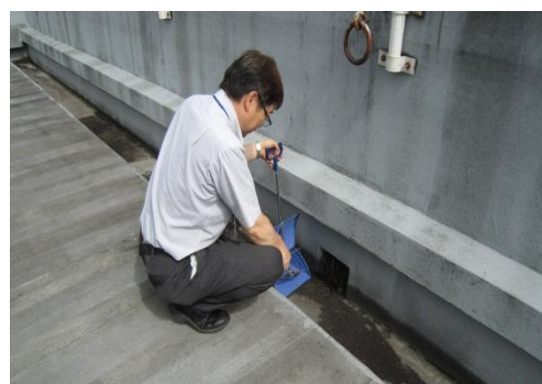
建物屋上清掃
