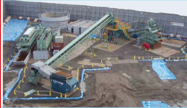
仮設洗浄処理プラント
