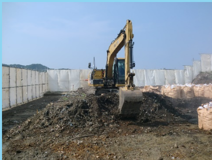
汚染土壌掘削除去
