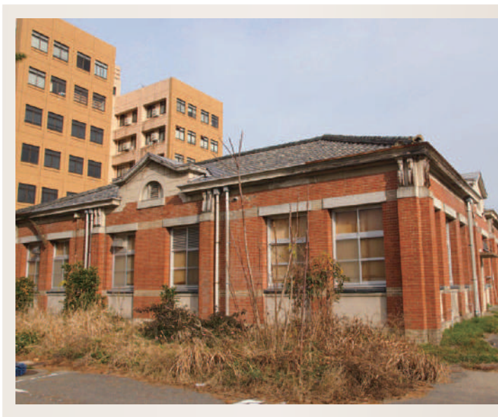
造船学実験室。赤煉瓦が目立つが、外壁基礎部分などに八幡製鐵所製鉋煉瓦も使用(2017年1月)。
