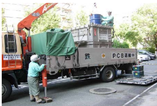
高圧コンデンサの搬出状況
