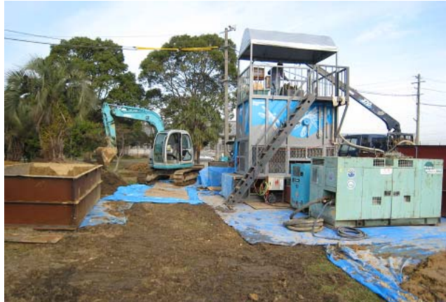
掘削および汚染土壌処理プラント
