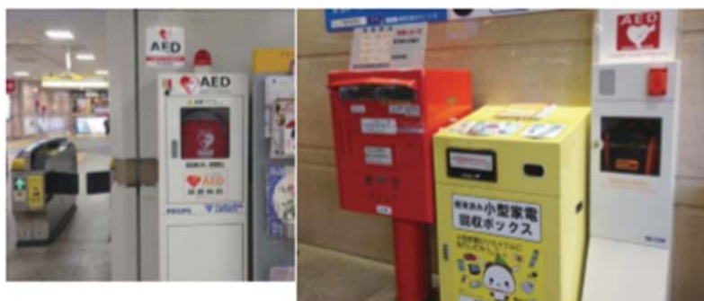
図 5.7 AEDの設置状況事例（厚生労働省、2015）
