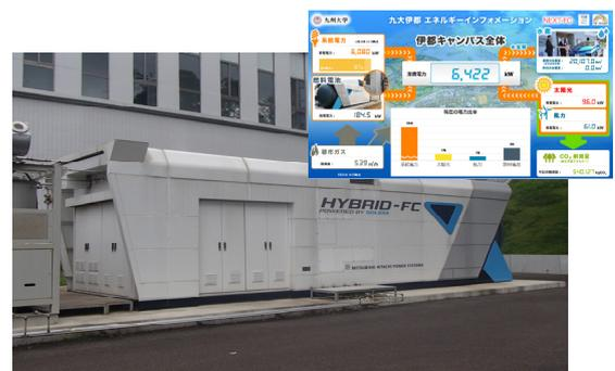
250kW級 燃料電池発電設備
