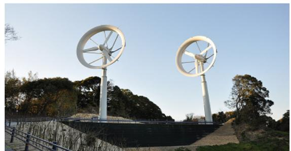
70kW×2 風レンズ型風力発電設備
