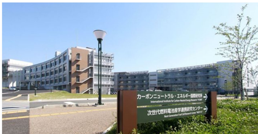
I 2 CNER 研究棟の外観
