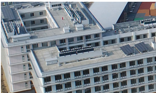
イースト1号館屋上の太陽光発電設備
