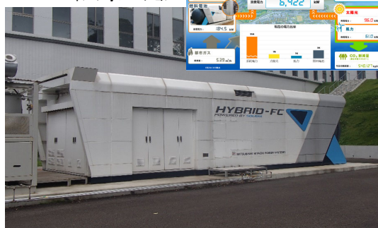
250kW級 燃料電池発電設備
