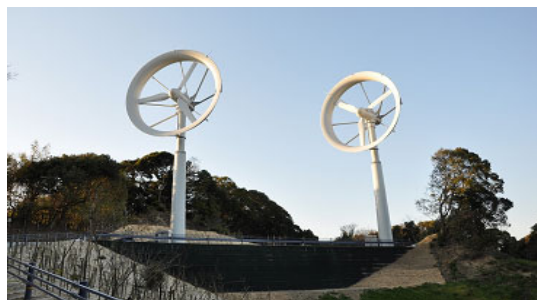
70kW×2 風レンズ型風力発電設備
