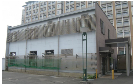
写真1 エコセンター
