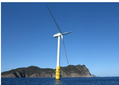
2MW スパー型浮体式風車
